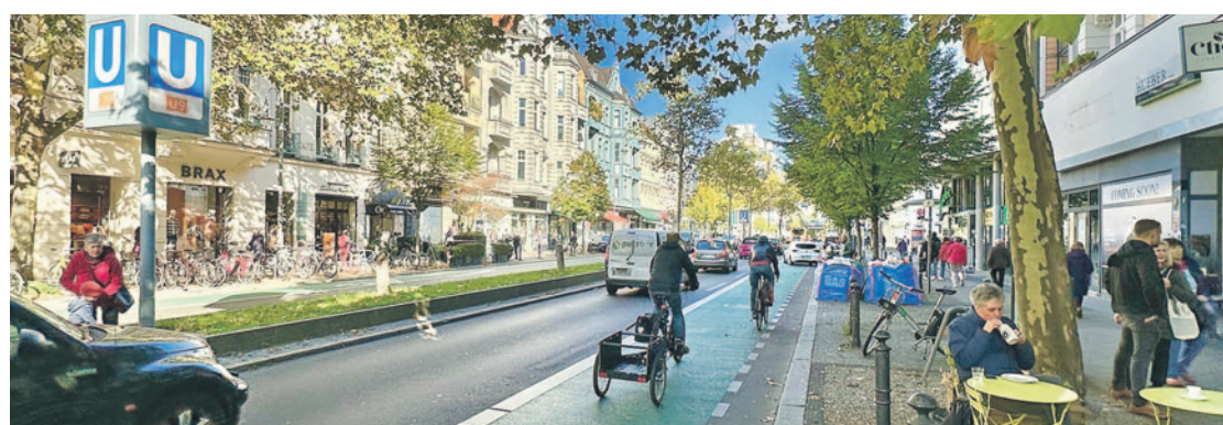
Zahlreiche neue Radwege wurden in Steglitz-Zehlendorf (im Bild die Schloßstraße) gebaut und bestehende saniert.
